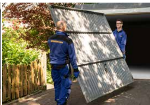
Ausbau und umweltgerechte Entsorgung
